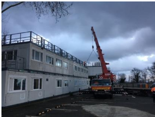
Démontage de la base vie
